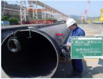
歪みゲージ設置
