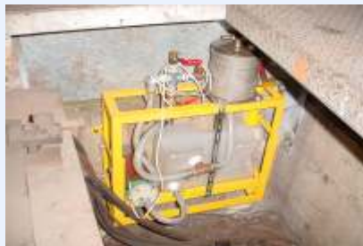
連通管式沈下計
