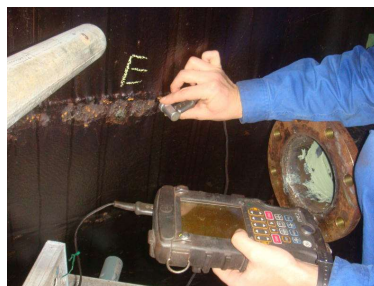
吸出管測定状況
