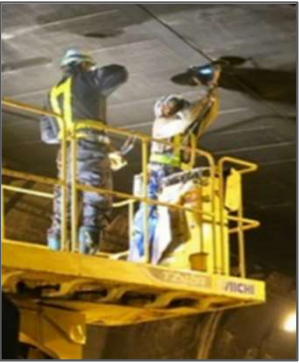
現在の打音検査状況 (近接目視点検)
