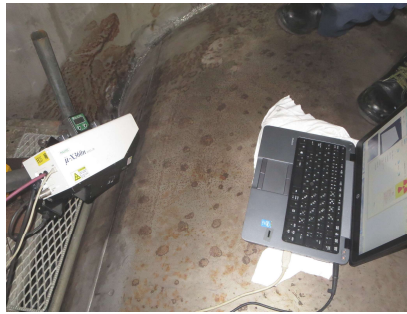
ステンレス鋼製タンクの 溶接部
