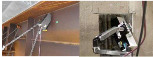
橋梁(ウェブ部,鉄筋部)
