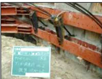
アンカーの張力を監視
