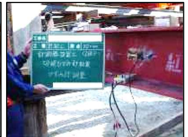
切梁に発生する軸力 を監視
