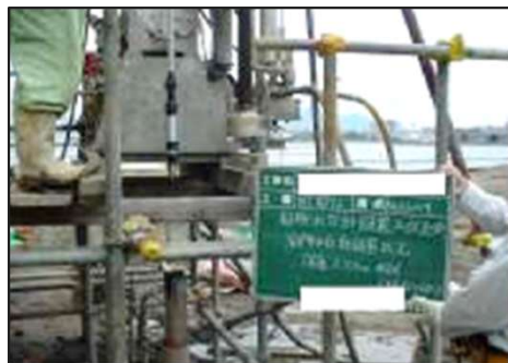
工事中の地下の水圧を 監視(測定)
