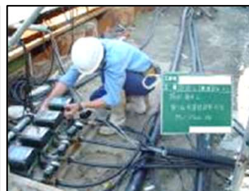
掘削時の地盤の沈下や掘削地と周辺の水の 浮き上がりを監視
