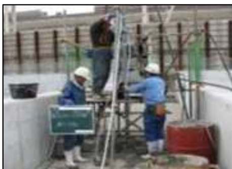
掘削時の地盤の浮き 上がり量を計測
