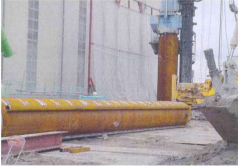
新若戸道路トンネル若松側陸上トンネル部本体工事
