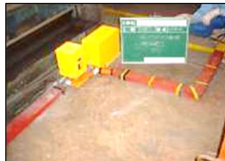
周辺施設の傾斜を 監視(測定)
