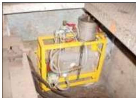
周辺施設の沈下量を 監視(測定)
