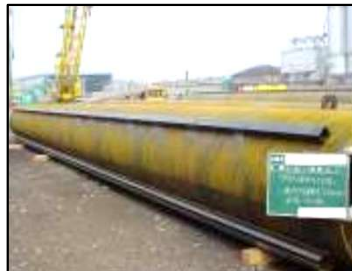
鋼管矢板の傾斜把握
