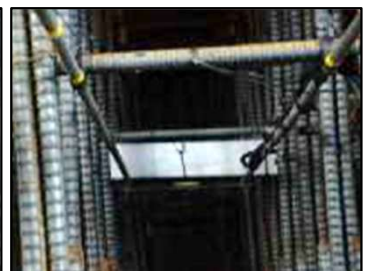
セメント硬化時の コンクリートに発生 する応力を測定
