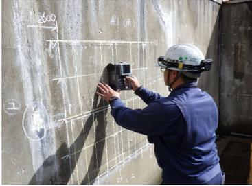
▶非破壊で構造物の鉄筋の配筋状態、かぶり厚などの調査が可能
